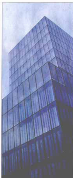
Wie das Lava-Gestein Obsidian wirkt die Fassade am neuen Zürcher Büroturm. (Fotos: Glas Marte)
