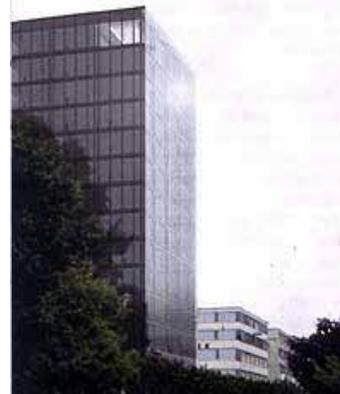
Stahlbetonskelettkonstruktion mit Stützen im Raster von 5,80 x 5,80 m lässt Nutzungen vom Einzel- bis zum Großraumbüro zu (Bilder 3, 4).
